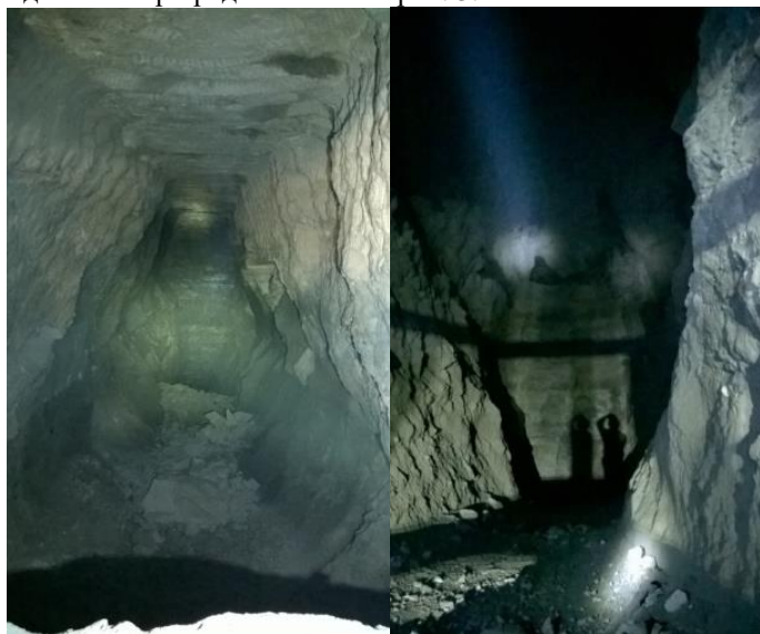
Рисунок 3 – Выработанное пространство ромбовидной камеры (верхние и нижние борта)
